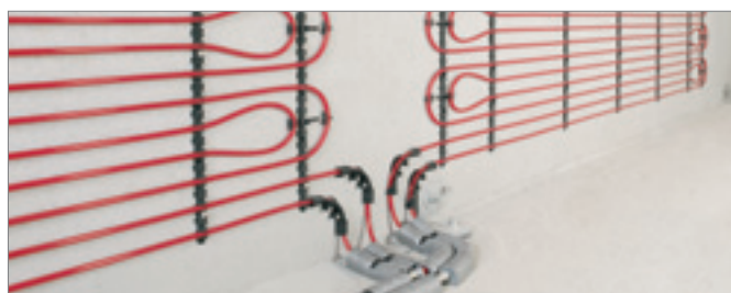
Система настенного отопления/охлаждения («мокрый» способ укладки труб)
